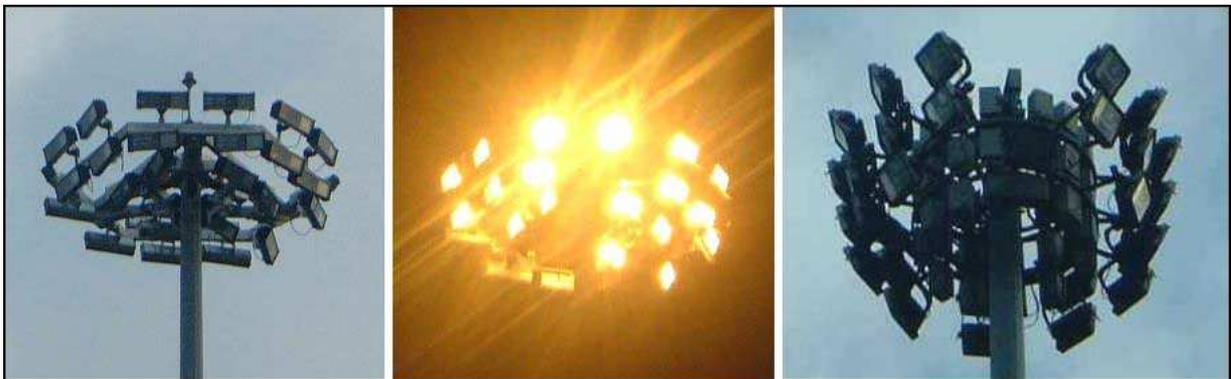
**Fig.6** - Torri faro molto inquinanti (a causa della configurazione e dell'inclinazione degli apparecchi utilizzati).
