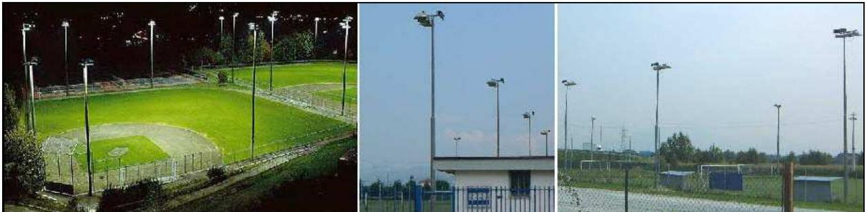
**Fig.9 -** Impianti sportivi illuminati in modo conforme alla L.r. 17/09 con proiettori asimmetrici orientati orizzontalmente e che non disperdono luce verso l'alto.
