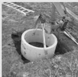
Sono cisterne sotterranee di forma quadrata o circolare che vengono alloggiare in contenitori di materiale plastico precedentemente inseriti nel terreno oppure ricoperte in terra battuta o in ghiaio. Possono essere collegate tra loro per il drenaggio di vaste aree aumentando la loro efficacia nella riduzione del rischio idraulico.
