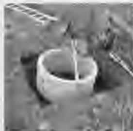
Sono cisterne sotterranee di forma quadrata o circolare che vengono alloggiate in contenitori di materiale plastico precedentemente inseriti nel terreno oppure ricoperte in terra battuta o in ghiaio. Possono essere collegate tra loro per il drenaggio di vaste aree aumentando la loro efficacia nella riduzione del rischio idraulico.
