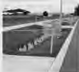
Sono formati da zone depresse lineari di vegetazioni che raccolgono flussi d'acqua da zone impermeabili. Dove possibile, possono essere progettati in modo da consentire infiltrazioni. Possono sostituire i sistemi convenzionali di drenaggio dell'acqua.
