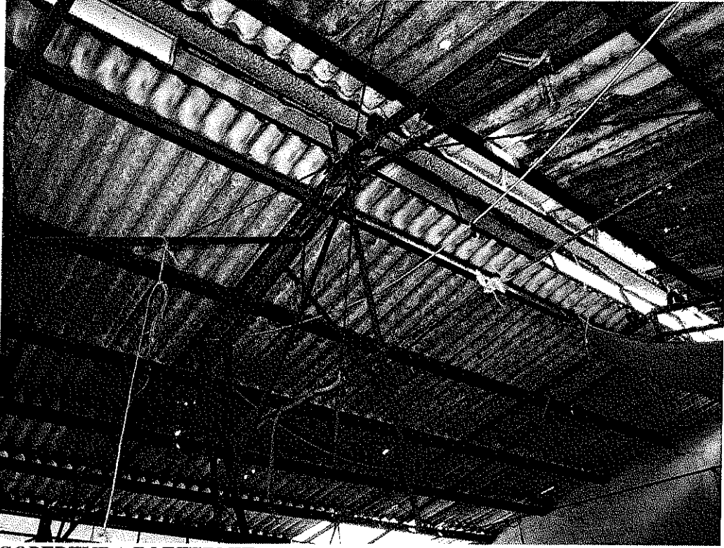
COPERTURA IN ETERNIT
